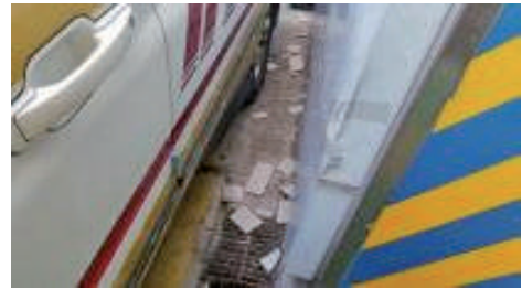
본서 외벽 타일 탈락
