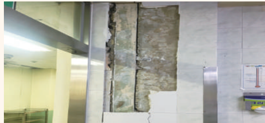
화장실 타일 탈락
