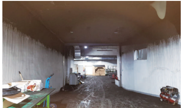
화재 발생 후 건물 내부에 화재 잔재물 및 유해 연기 확산
