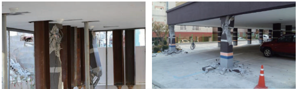
필로티 구조 건축물 피해 사진
