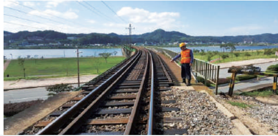
선로변형 점검 〈중앙선 안동-무릉 간 낙동강교량〉
