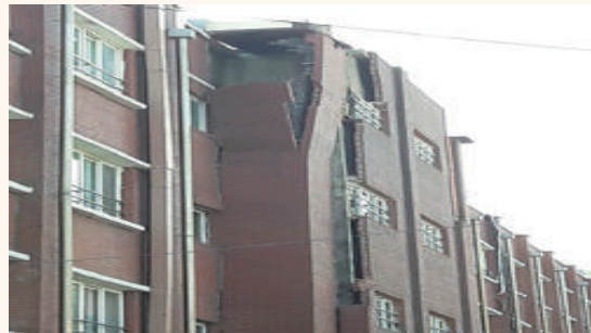
외벽 치장벽체 탈락 및 붕괴위험
