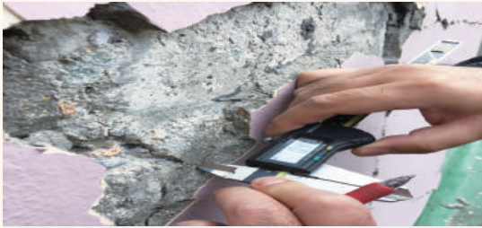
기둥 균열 발생
