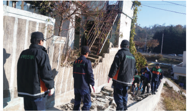
주택담장 철거 작업
