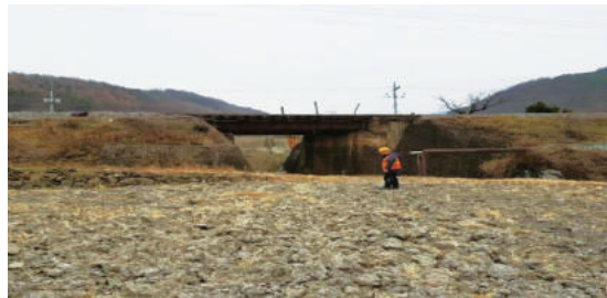
진앙지 인접 구간 액상화 점검 〈중앙선 의성-북영천 간〉
