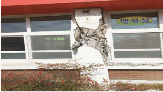
1층 전면부 기둥 파괴
