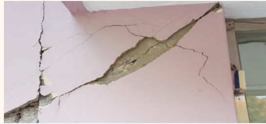
기둥 균열 발생
