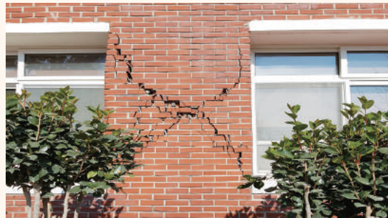
1층 기둥 마감(치장)벽돌재 탈락
