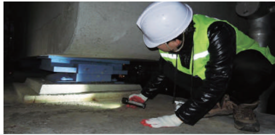
교량받침 및 하부구조 점검 〈경부고속선 대전-김천구미 간 판암1교〉
