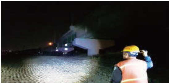
진앙지 인접 구간 액상화 점검 〈동해선 신부조-포항 간〉
