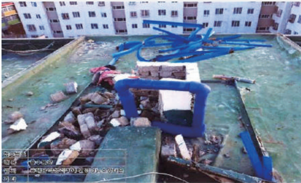
공동주택 옥상 물탱크 파손으로 인한 응급조치
