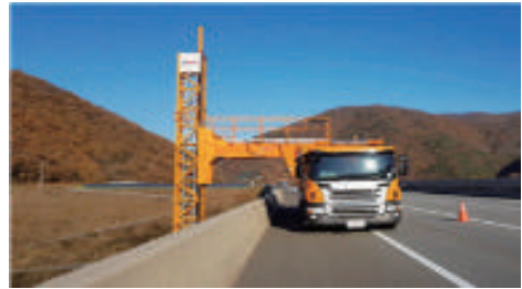
교량점검차 활용 점검
