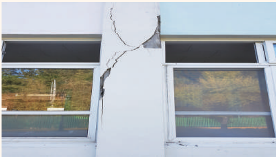
1층 기둥 균열 발생
