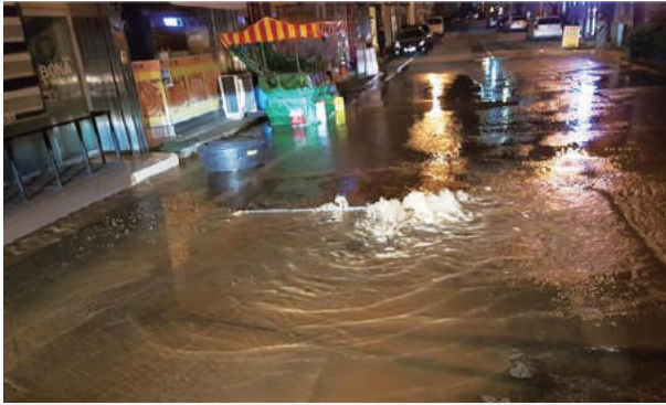
포항 장성동 866-257 장성시장 앞 누수 전경 (D75)
