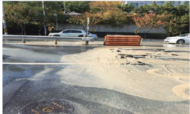
환호동 환호해맞이그린빌 앞 누수 전경(D450)
