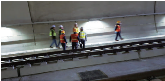
터널 갱문 및 주변 지형 점검 〈동해선 신부조-포항 간 자명2터널〉
