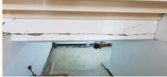
지하층 보 균열(본관동)
