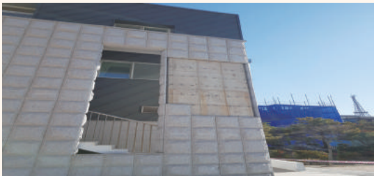
외부 마감재 탈락
