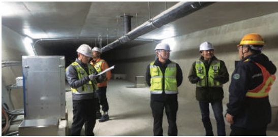
교량 점검 (PC박스 내부) 〈경부고속선 동대구-부산 간 송선교가교〉
