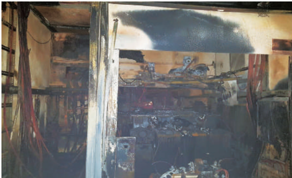
지진으로 인한 화재 발생, 지하 전기실 전소
