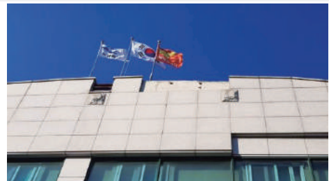
흥해센터 외벽 화강석 탈락
