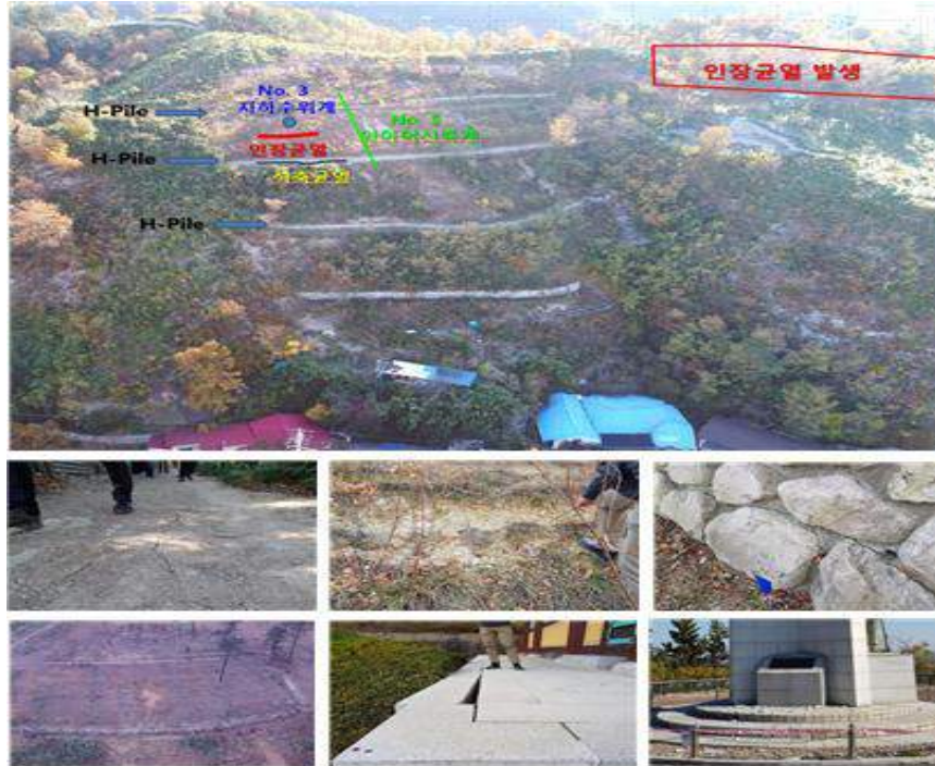
지진에 의해 인장균열, 표층붕괴, 시설물 손상 등 다수 발생
