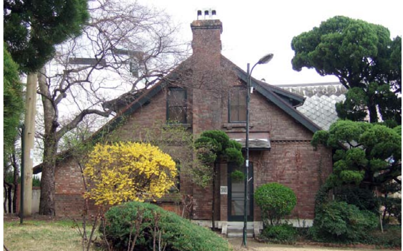
△블레어 주택 전경
