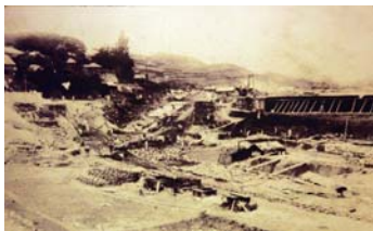
△건설당시 터널바닥굴착 (멘부란식공법)공사 사진
