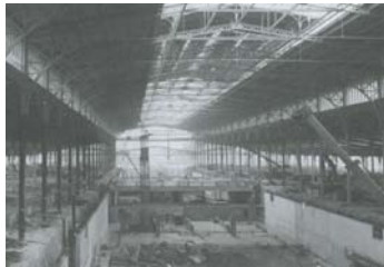
△공사 중(지하 구조물 추가)
