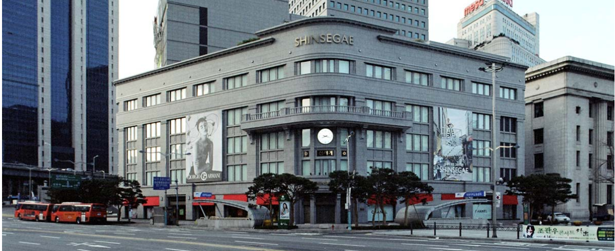
△신세계백화점 본관 전경(개수후)
