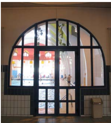
△수영장 내부 아치
