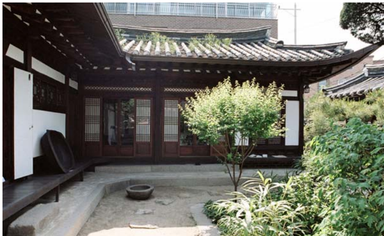
△최순우 옛집 내부 전경
