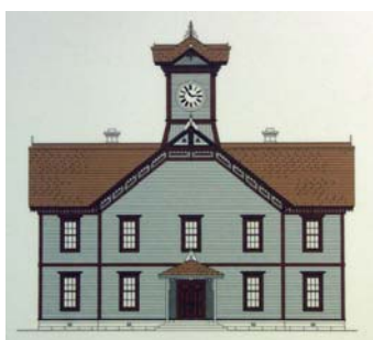
△삿포로시 시계탑 건립당시 정면
