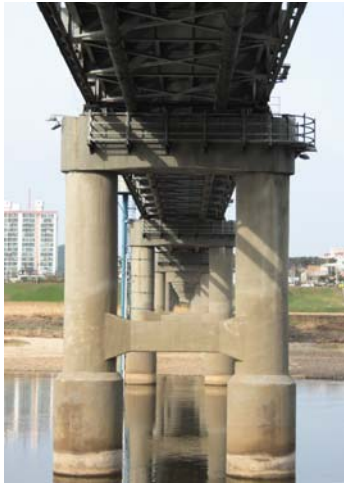
△금강철교 하부 교각
