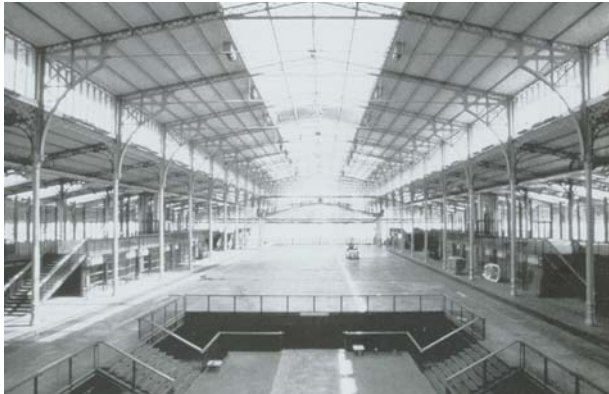
△공사 후의 모습
