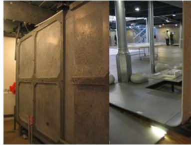
△상설전시장의 콘크리트 벽면
