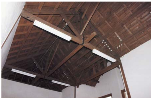
△지붕 전경 (출처: 신촌역사 이전(개축) 공사보고서)
