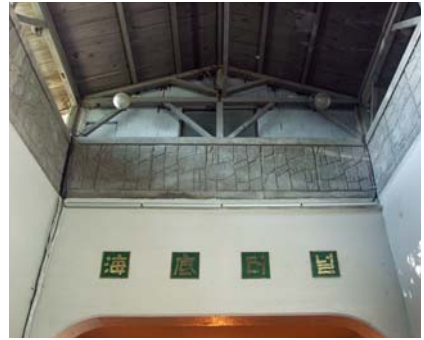
△해저터널 상부 전경
