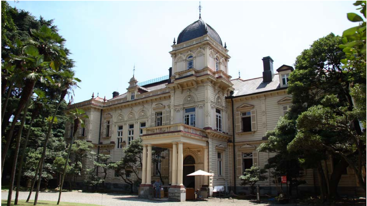
△구 이와사키저택의 정면
