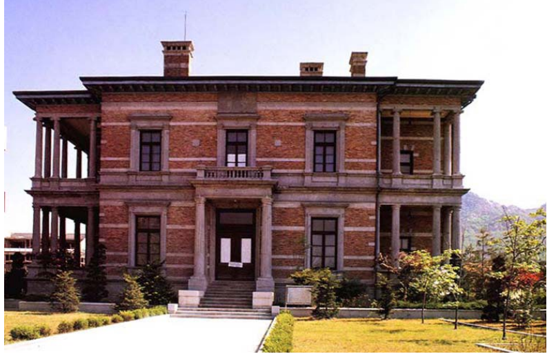
△구 벨기에 영사관 전경
