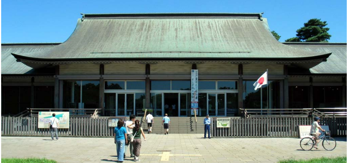
△방문자센터(구 광화전, Center Zone) 전경
