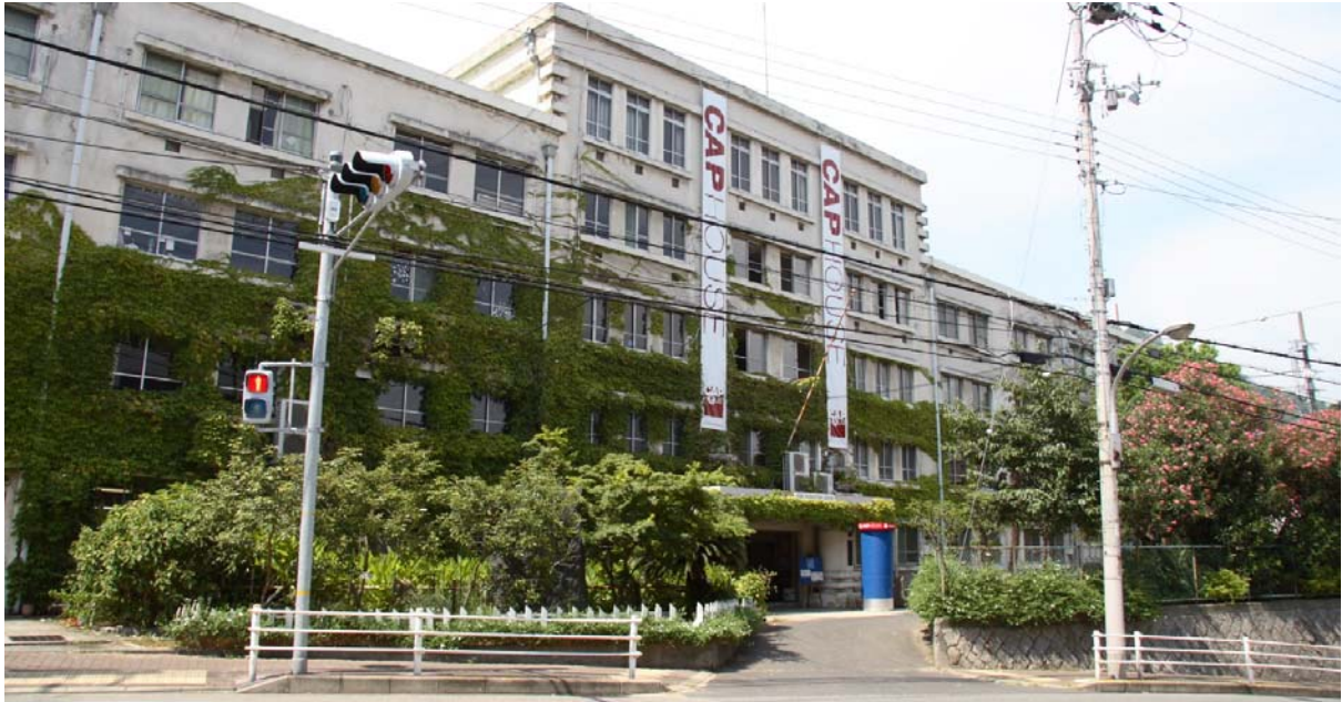
△CAP HOUSE 전경
