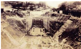
△건설당시 기초콘크리트 타설공사 사진
