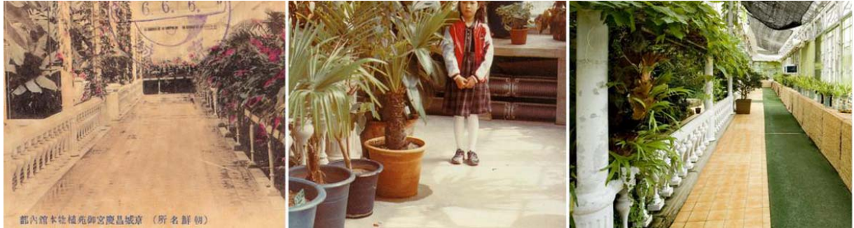
그림 82 내부 바닥마감재의 변화과정 왼쪽부터 벽돌(일제강점기 추정), 시멘트 미장(1980년대), 타일(현재)로 변화
