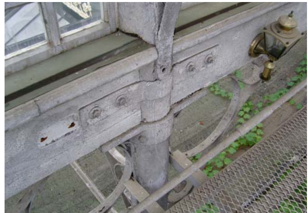
그림 46 주철기둥과 목재도리가 만나는 부분
