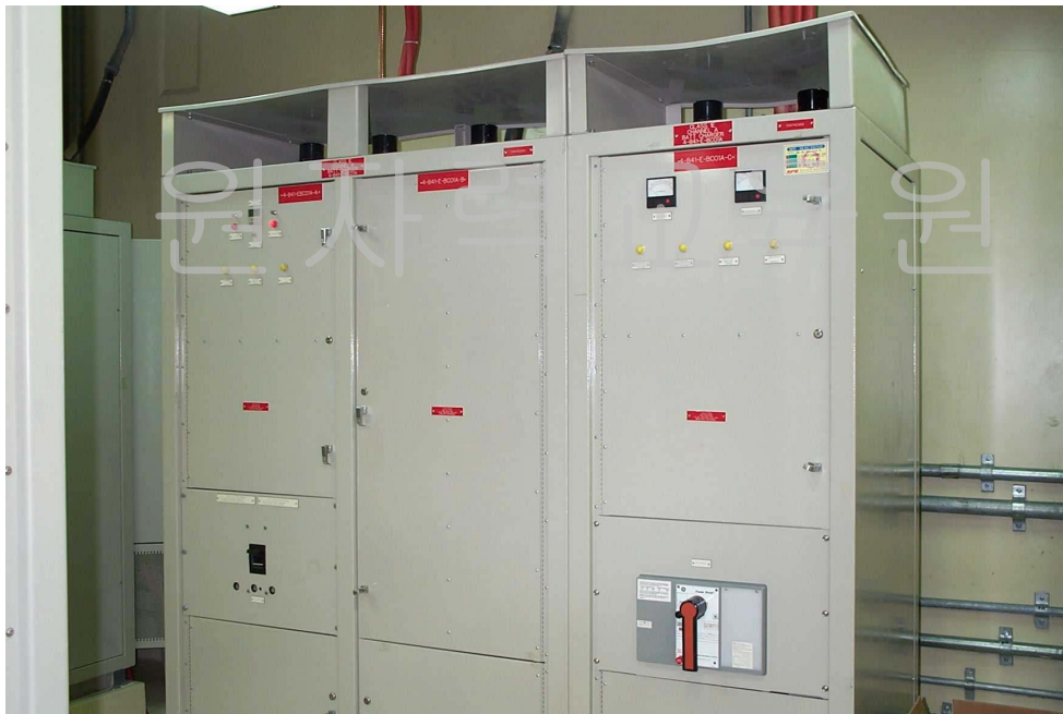
[그림 3-107] 전기-1급 충전기(울진3호기)
