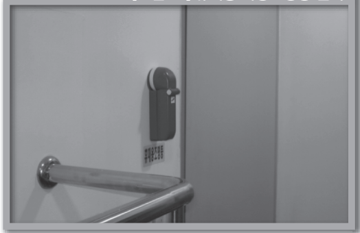
[그림 76] 휴대용 비상조명등 설치
