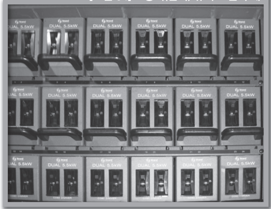
[그림 34] 조광기(디머) 유니트 설치 예
