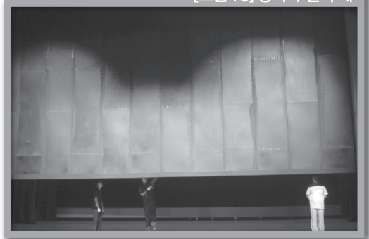
[그림 78] 방화막 설치 예
