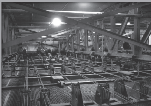
[그림 21] 공연장 상부 그리드 및 건축구조물
