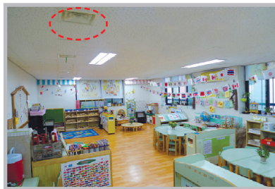
(나) 급기팬 설치
