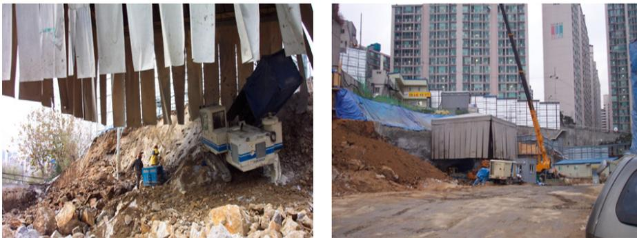
② 땅 천공 시 어스오거(earth auger)장비 방진망(포) 설치 사례
