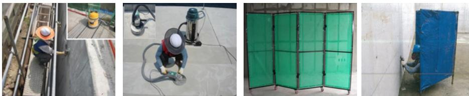
① 연삭기에 진공청소기 부착(1)    ② 연삭기에 진공청소기 부착(2)    ③ 이동식 방진막 설치(1)    ④ 이동식 방진막 설치(2)
