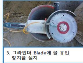
3. 그라인더 Blade에 물 유입 장치를 설치
