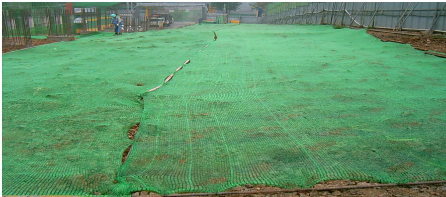
법면 보호덮개 설치 및 내부도로 가포장
